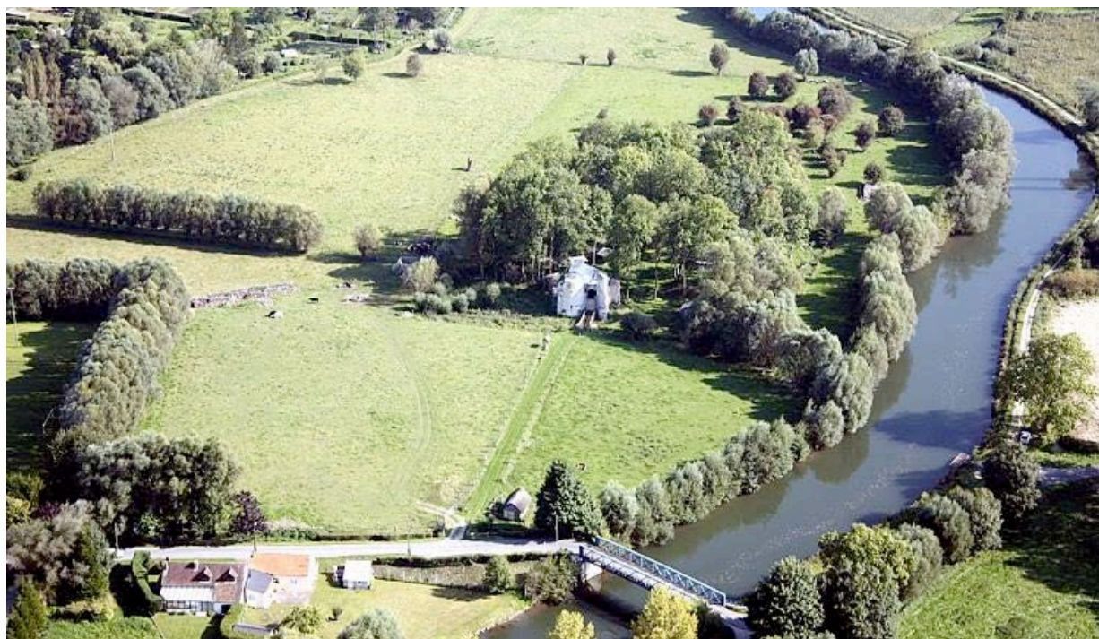
Fig. 1 : Les « Aires du château » d'Eaucourt © 2010, A. Bron
